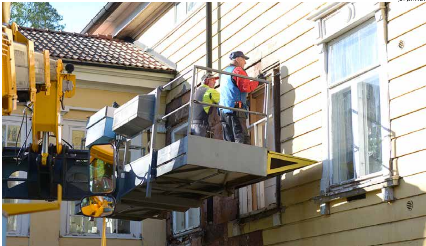
Pertti Reunanen ja Keijo Vähäaho ovat korjanneet Euran pappilan ulkolaudoitusta ennen rakennuksen maalausta.
